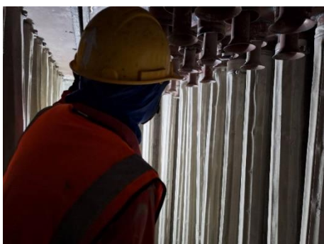
รูปที่ 9 การเปลี่ยนและตรวจสอบถุงกรอง
