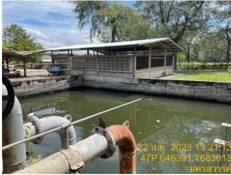
รูปที่ 25 บ่อพักน้ำที่มาจากระบบหล่อเย็น
