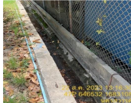
รูปที่ 41 รางระบายน้ำฝนหลักของโครงการ
