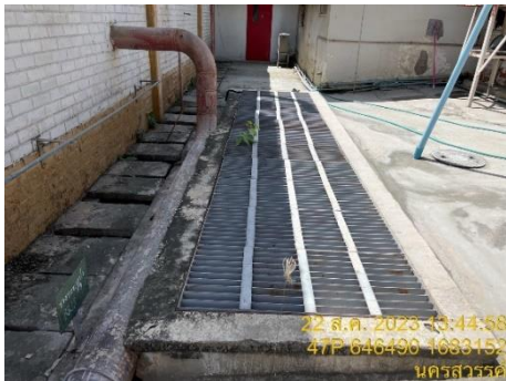
รูปที่ 25 บ่อพักน้ำที่มาจากระบบหล่อเย็น
